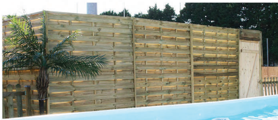
Bradage bois, panneaux blancs
